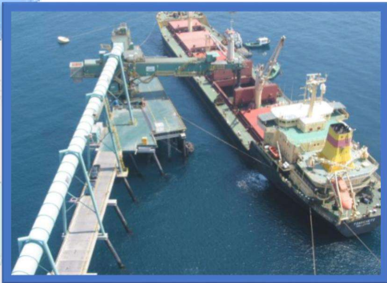
FOTO N° 05: TERMINAL PUNTA LOBITOS ANTAMINA Exportación de concentrados de cobre y zinc Muelle tipo Dolphin de 271 m. de eslora y 20 m. de calado.
