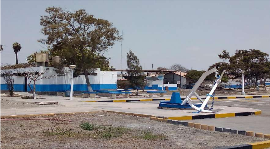
Pintado de los Exteriores del Terminal Portuario de Chimbote
