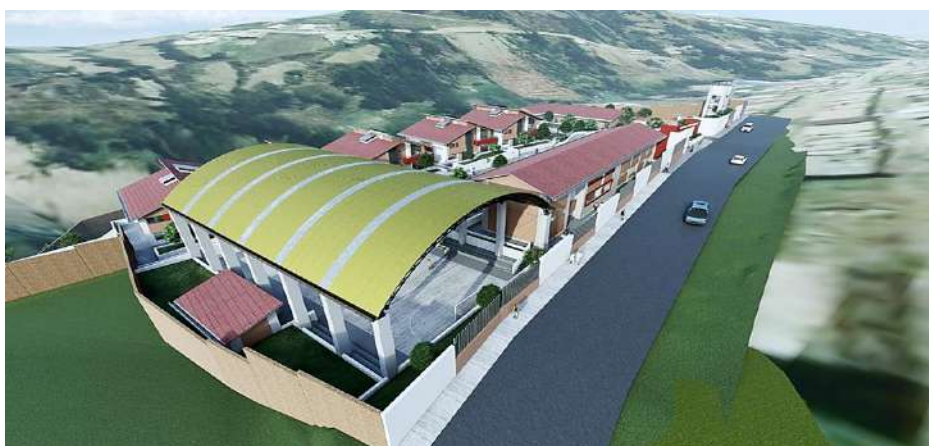
IMAGEN 01: VISTA AEREA GENERAL DEL PROYECTO. (LATERAL IZQUIERDO)
