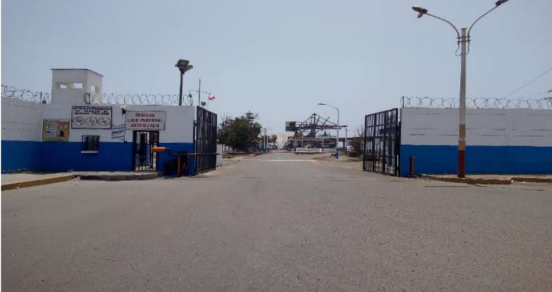
Pintado de la zona donde se ingresa a los Muelles 01 y 02 del Terminal Portuario de Chimbote
