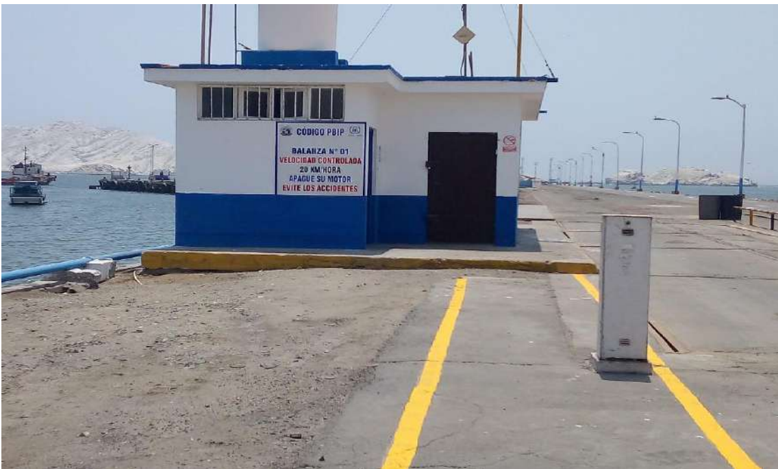
Pintado de la Balanza N°01 del Terminal Portuario de Chimbote
