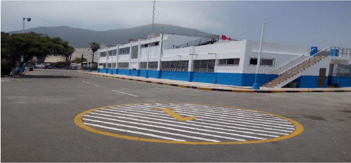
Pintado de los exteriores del Terminal Portuario de Chimbote
