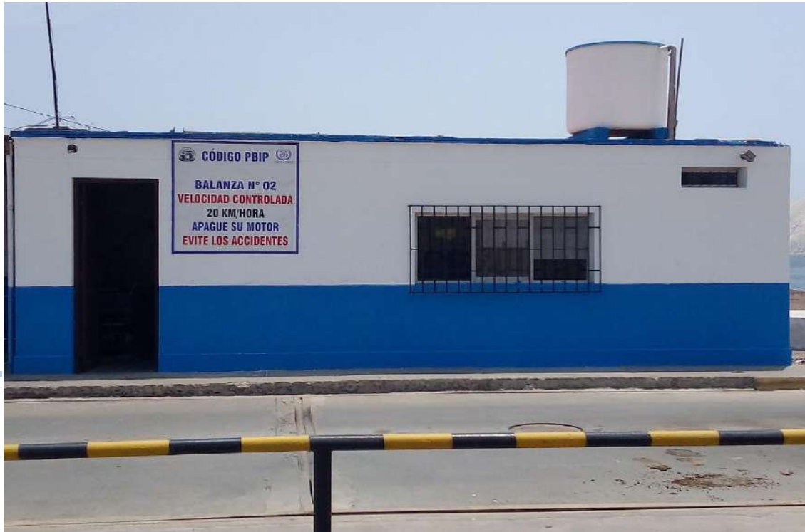
Pintado de la Balanza N° 02 del Terminal Portuario de Chimbote
