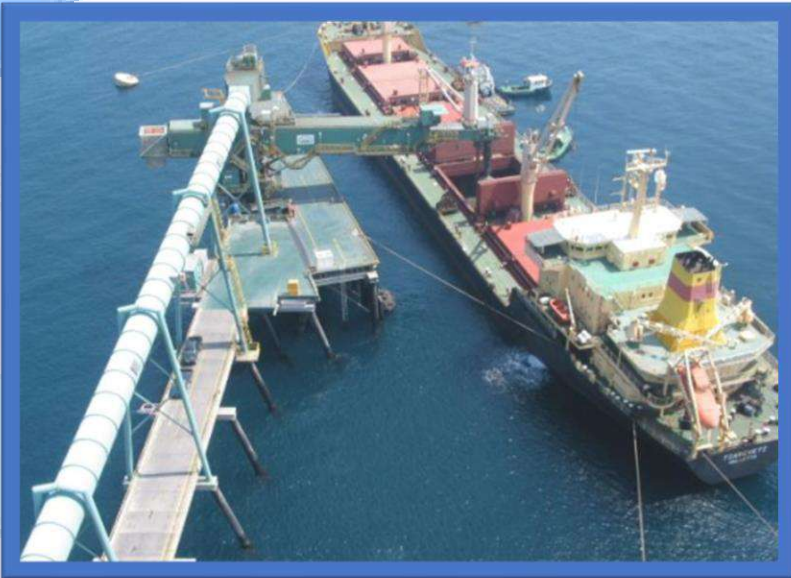
FOTO N° 05: TERMINAL PUNTA LOBITOS ANTAMINA Exportación de concentrados de cobre y zinc Muelle tipo Dolphin de 271 m. de eslora y 20 m. de calado.
