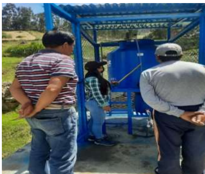
Imagen N° 06: Inspección del Sistema de Cloración
