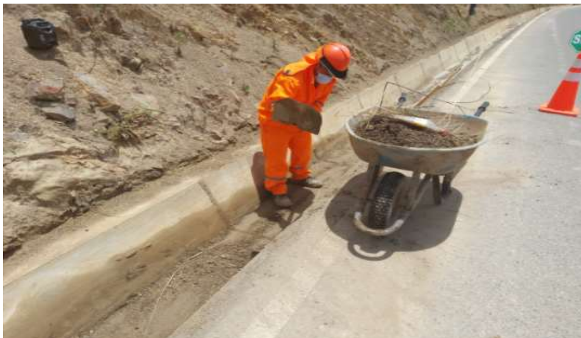
Fotografía 01: Limpieza de Cuneta en la Carretera Departamental Pavimentada AN -107
