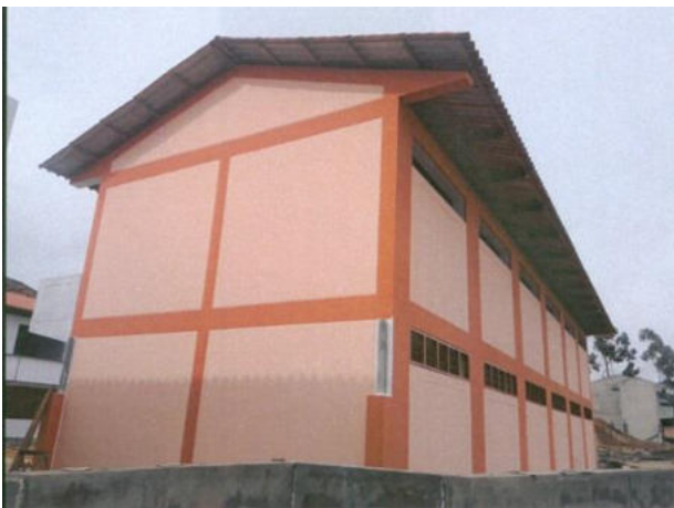
CONSTRUCCION DE LA INFRAESTRUCTURA DE LA I.E. ANTONIO RAIMONDI DE LLAMELLIN DE LA PROVINCIA DE ANTONIO RAIMONDI - REGION ANCASH (OBRA EN EJECUCION - 83.89%)
