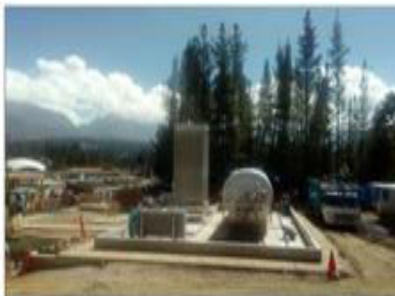
Estación de Distrito Huaraz
