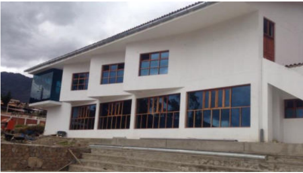
MEJORAMIENTO DE LOS SERVICIOS EDUCATIVOS DE LA INSTITUCION EDUCATIVA AMAUTA - ATUSPARIA, DISTRITO DE CHACAS, PROVINCIA DE ASUNCION, DEPARTAMENTO DE ANCASH (OBRA CULMINADA)
