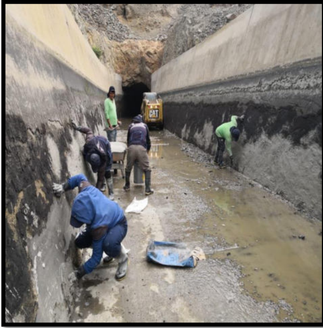
Resane con mortero de las grietas en la pared de caja hidráulica prog. 11+282 hasta la prog. 16+200 del canal de derivación del Sistema la HUACA.
