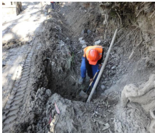
Corte de derrumbes y material suelto
