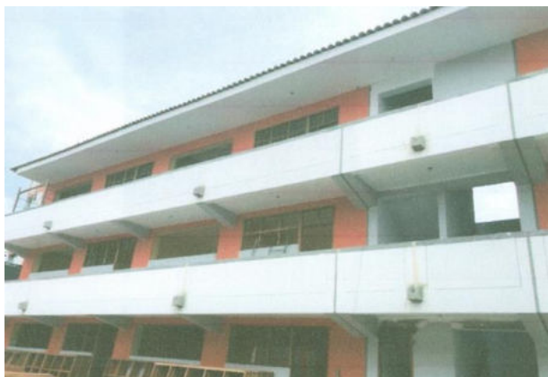
MEJORAMIENTO DE LOS SERVICIOS EDUCATIVOS DE LA I.E.P. SAN ROQUE DE MANCOS, DISTRITO DE MANCOS - YUNGAY – ANCASH (OBRA CULMINADA)
