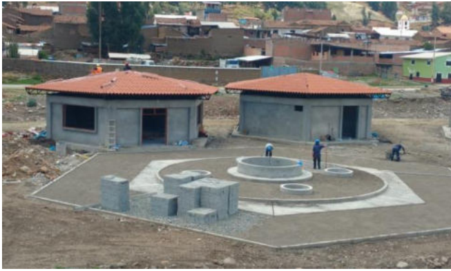
MEJORAMIENTO Y AMPLIACION DEL CENTRO TEMATICO CULTURA RECUAY, PARA LA EDUCACION Y CAPACITACION EN LOS SERVICIOS ECOLOGICO, DEPORTIVO, CULTURAL Y ARTESANAL, DISTRITO DE RECUAY, PROVINCIA DE RECUAY-ANCASH (OBRA EN EJECUCION - 82.06%)
