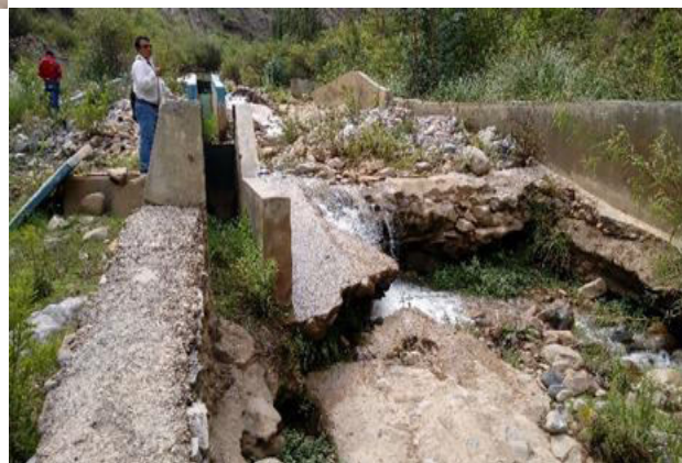
Fotografía N° 03. Se observa canal deteriorado (trabajos de campo para perfil)
