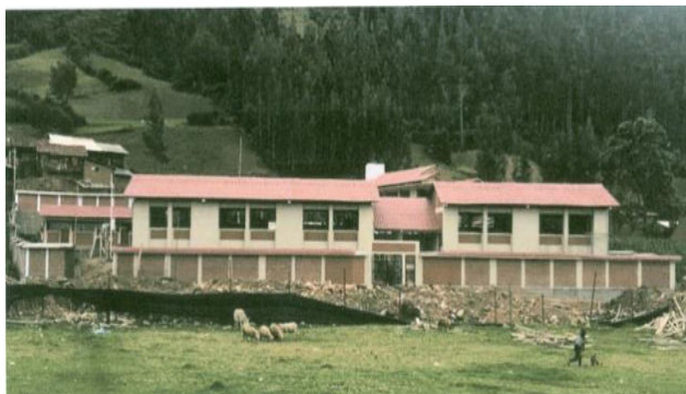
MEJORAMIENTO DE LOS SERVICIOS EDUCATIVOS DE LA INSTITUCION EDUCATIVA N° 86335 DEL NIVEL PRIMARIO DE CAJAY, DISTRITO DE CAJAY-HUARI – ANCASH (OBRA EN EJECUCION - 89.60%)
