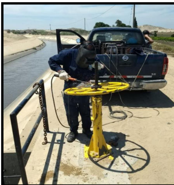
Toma 10 del Canal Principal progresiva 45+900, se encontró la plancha de compuerta cortada en la base, el cual se efectuó la reparación de la compuerta.
