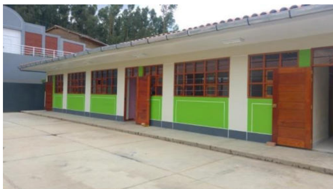
CREACION DE LA INFRAESTRUCTURA EDUCATIVA DE LA I.E. N° 084 DEL BARRIO DE VILLA SUR DEL DISTRITO DE SAN LUIS PROVINCIA DE CARLOS FERMIN FIZCARRAL-ANCASH (OBRA CULMINADA)
