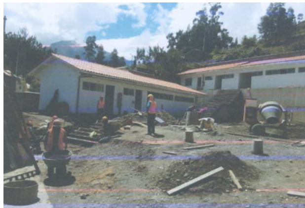
INSTALACION DE LOS SERVICIOS DE EDUCACION INICIAL ESCOLARIZADA DE LA I.E. N° 448 DE LA LOCALIDAD DE YANARUMI DEL DISTRITO DE SHILLA, PROVINCIA DE CARHUAZ-DEPARTAMENTO DE ANCASH (OBRA PARALIZADA - 90.39%)
