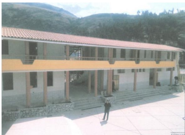
MEJORAMIENTO DE LOS SERVICIOS EDUCATIVOS DE LA I.E.P. N° 86638 NESTOR EDMUNDO ESCUDERO OLIVEROS DE CHALHUA, DISTRITO DE YANAMA, PROVINCIA DE YUNGAY, DEPARTAMENTO DE ANCASH (OBRA CULMINADA)
