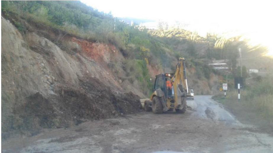
TRABAJOS EN LA CARRETERA DEPARTAMENTAL AN-109 Tendido de material seleccionado para plataforma
