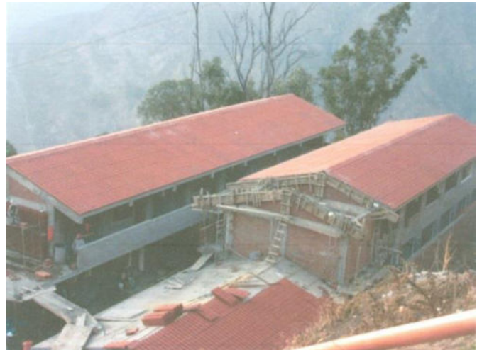
MEJORAMIENTO Y AMPLIACION DE LA OFERTA DE LOS SERVICIOS EDUCATIVOS I.E. N° 88134 PEDRO PABLO ATUSPARIA PRIMARIA Y SECUNDARIA EN EL BARRIO SAN CRISTOBAL, DISTRITO DE YANAC-CORONGO-ANCASH (OBRA CULMINADA)
