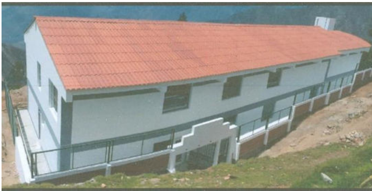
REHABILITACION Y MEJORAMIENTO DE LOS SERVICIOS DE SALUD DEL PUESTO DE SALUD DEL CASERIO DE YANAC, DISTRITO DE YANAC-CORONGO-ANCASH (OBRA CULMINADA)
