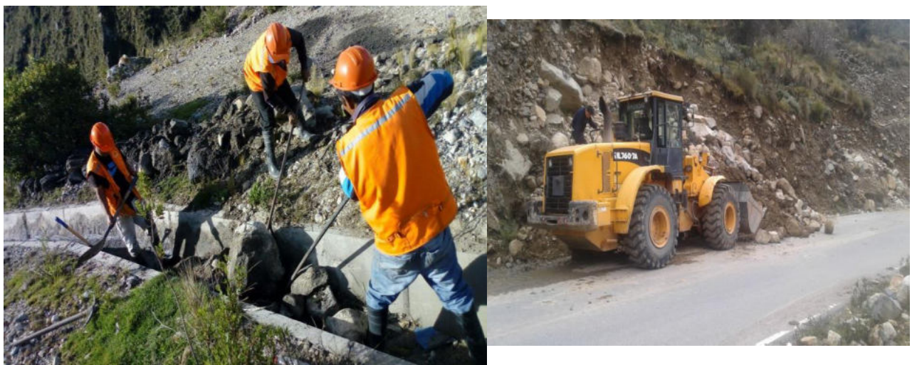
Corte de derrumbes y material suelto
