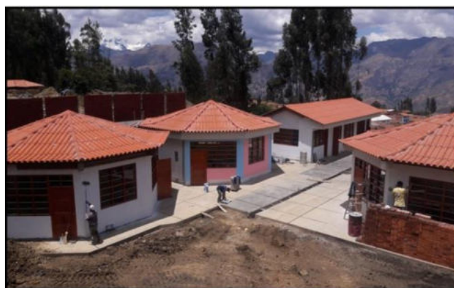
MEJORAMIENTO DEL SERVICIO EDUCATIVO DE LA I.E.I. N° 248 VIRGEN PURISIMA DEL CONVENTO, DISTRITO DE PISCOBAMBA, PROVINCIA DE MARISCAL LUZURIAGA-ANCASH (OBRA CULMINADA)
