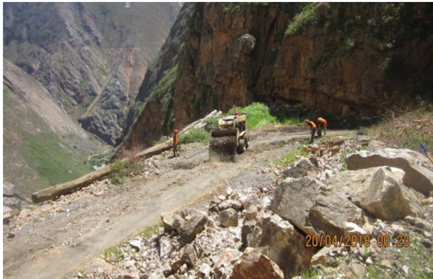
TRABAJOS EN LA CARRETERA DEPARTAMENTAL AN-109 Tendido de material seleccionado para plataforma
