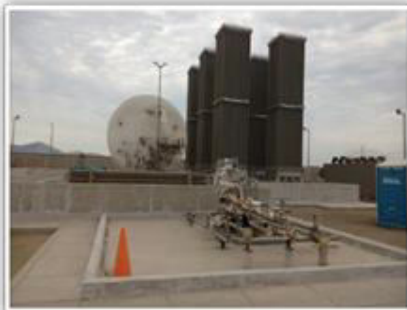
Estación de Distrito Chimbote
