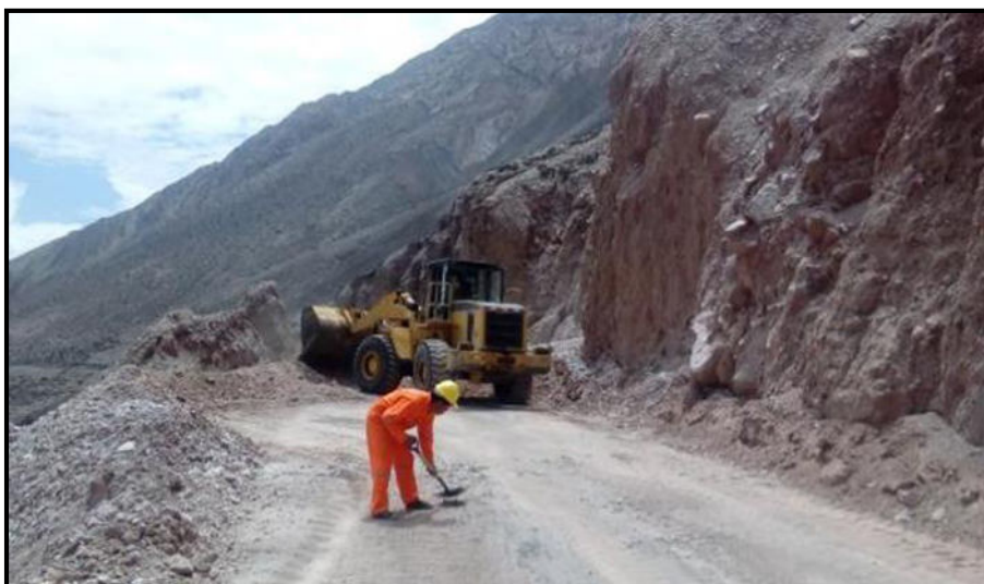
Fotografía: corte de derrumbes y material suelto
