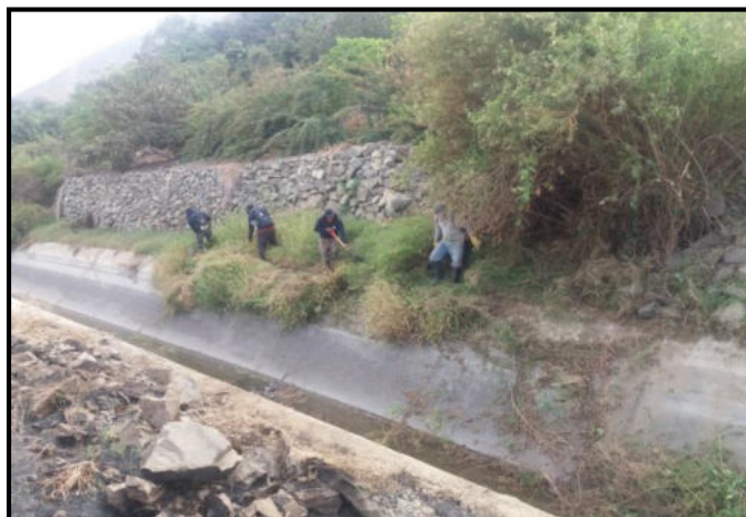
Limpeza manual de vegetación en zonas aledañas al Canal Chimbote prog. 5+000 al 10+000.
