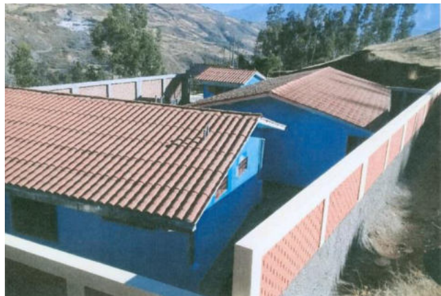
INSTALACION DE LOS SERVICIOS DE EDUCACION INICIAL ESCOLARIZADA DE LA I.E. N° 663 DE LA LOCALIDAD DE SAN ISIDRO DEL DISTRITO DE SHUPLUY, PROVINCIA DE YUNGAY - DEPARTAMENTO DE ANCASH (OBRA CULMINADA)
