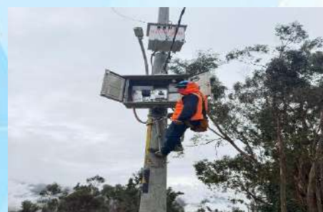
MEJORAMIENTO Y AMPLIACION DE LAS REDES PRIMARIAS 22.9 KV Y SECUNDARIAS 380/220 EN LA ZONA RURAL Y URBANA DEL DISTRITO DE MIRGAS - PROVINCIA DE ANTONIO RAYMONDI - DEPARTAMENTO DE ANCASH
