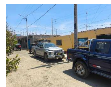
MEJORAMIENTO Y AMPLIACION DEL SISTEMA DE ELECTRIFICACION RURAL DE REDES PRIMARIAS Y SECUNDARIAS DEL SECTOR SAN ISIDRO-EX EL LABRADOR DEL DISTRITO DE COMANDANTE NOEL
