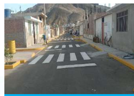
MEJORAMIENTO DEL SERVICIO DE TRANSITABILIDAD PEATONAL Y VEHICULAR DEL C.P LOS CHIMUS DEL DISTRITO DE SAMANCO - PROVINCIA DE SANTA - DEPARTAMENTO DE ANCASH
