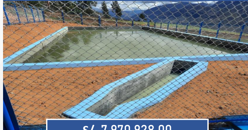
CANAL DE RIEGO HUARANGAL - ANRA
