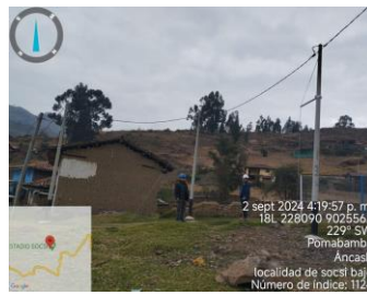
AMPLIACION Y CONSTRUCCIÓN DEL SISTEMA DE ELECTRIFICACION RURAL, RED PRIMARIA Y RED SECUNDARIA - LOCALIDADES DEL DISTRITO DE POMABAMBA
