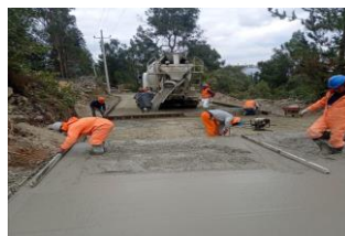
MEJORAMIENTO DEL SERVICIO DE TRANSITABILIDAD VEHICULAR Y PEATONAL EN EL TRAMO HUARAZ- PARIJA WILCAHUAIN, HUARAZ -
