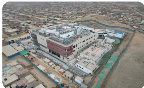
HUARMEY – 93.10% culmina diciembre 2024 ejecuta PRONIS Obras por Impuestos
